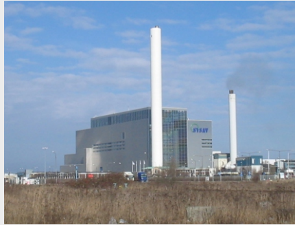
MVA Malmö (S)
